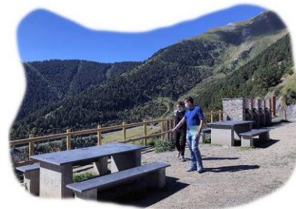
Berenador del mirador del Roc de la Sabina, després de les obres de renovació
